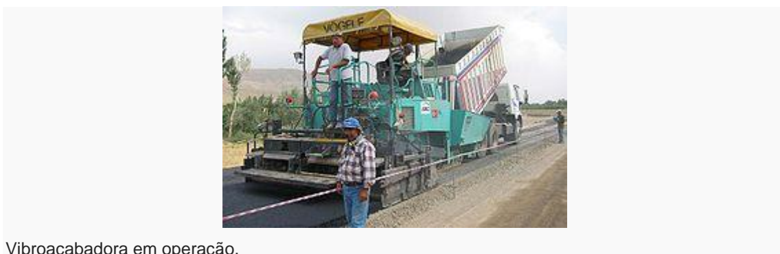
Vibroacabadora em operação.
